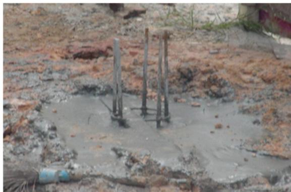
**Figura 3.** Estaca hélice logo após a execução (Manaus, AM).
