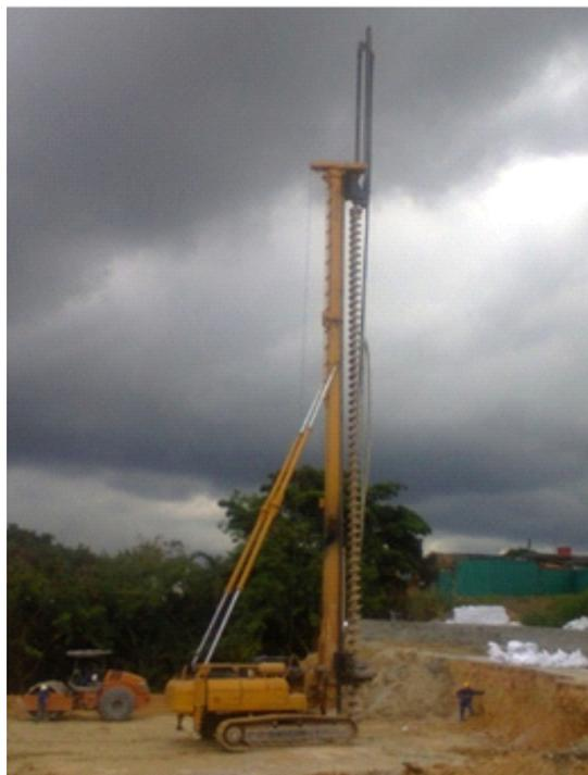
**Figura 2.** Máquina para execução da estaca hélice contínua monitorada (Manaus, AM).
