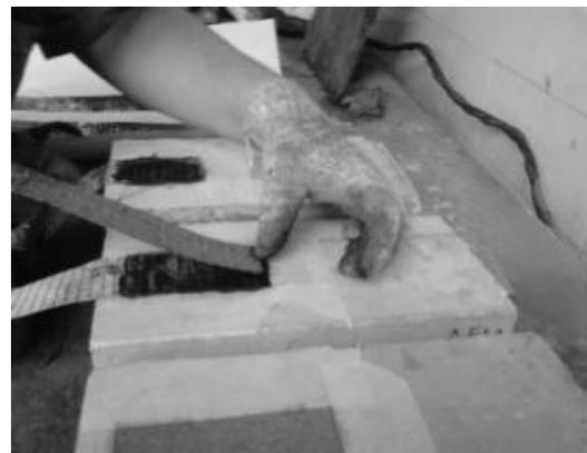
**Figura 9:** Aplicação da segunda camada de fibra.
