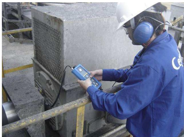
Figura 32: Momento da coleta de dados em um dos motores, com a utilização do sensor magnético (Braskem/Triunfo, 2010).
