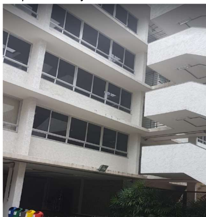
Figura 3: Fachada externa do Bloco 2 com película nas janelas das salas de aula
