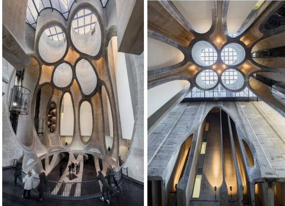
Figura 11: Zeitz Museum, MOCAA. Visitantes observando el Atrio central. (31)(32) Figura12: Zeitz Museum, MOCAA. Vista cenital del atrio central donde se pueden apreciar los cortes en los silos originales y los refuerzos interiores. Lucernarios en terraza superior. (31)(32)
